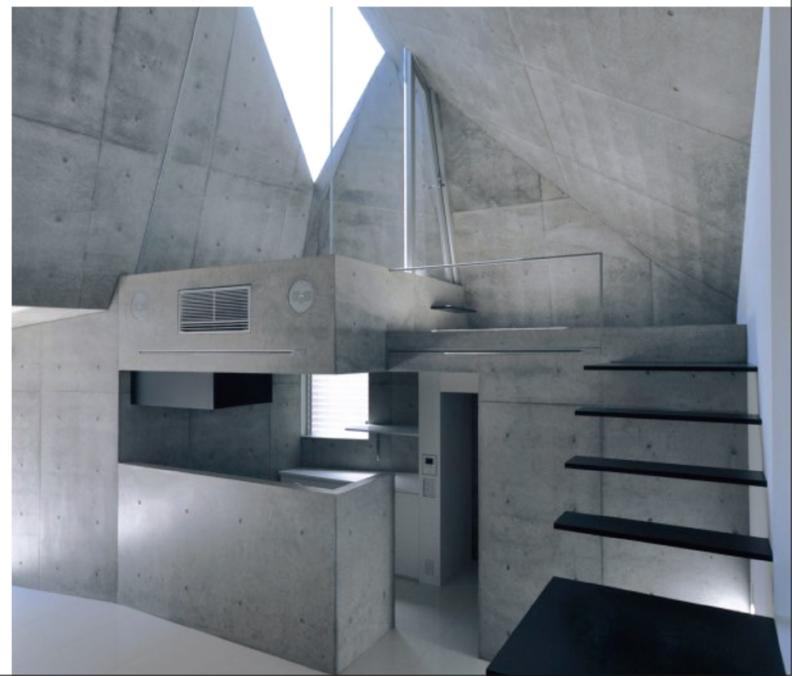
下垂直的連續牆面，形成結構應力合理傳達的結構型態，在這裡面你看不到任何的梁柱，因為全部的結構就是用『壁式結構』的系統來完成的，你可以想像完全用箱體或紙板去構築的結構體一樣，那是屬於『面的受力方式』，其力學與空間感都與純梁柱結構大大地不同。
